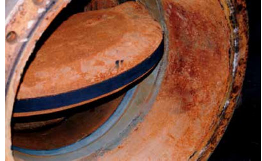
HYDROMAT® DN800, PN10: 30 Jahre im Netz, Dichtung in einwandfreiem Zustand, Armatur voll funktionsfähig.
